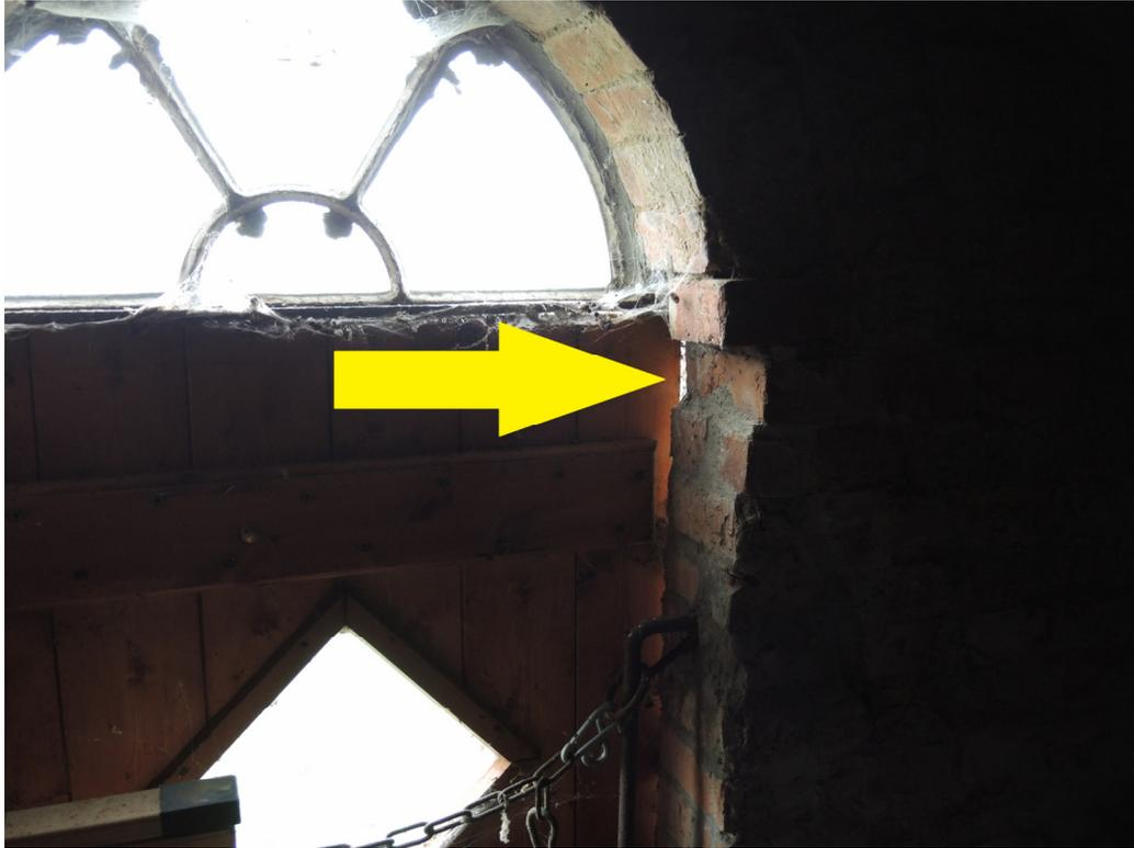
**Abb.: 1.** Einflugmöglichkeit in das Nebengebäude zwischen Luke und Mauerwerk (Ostgiebel)
