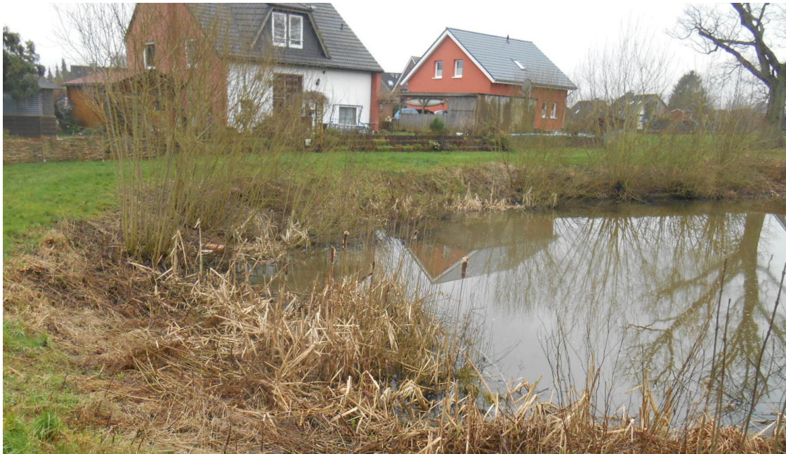
Abbildung 2: Das bereits vorhandene Regenrückhaltebecken liegt im Süden des Plangebiets.
