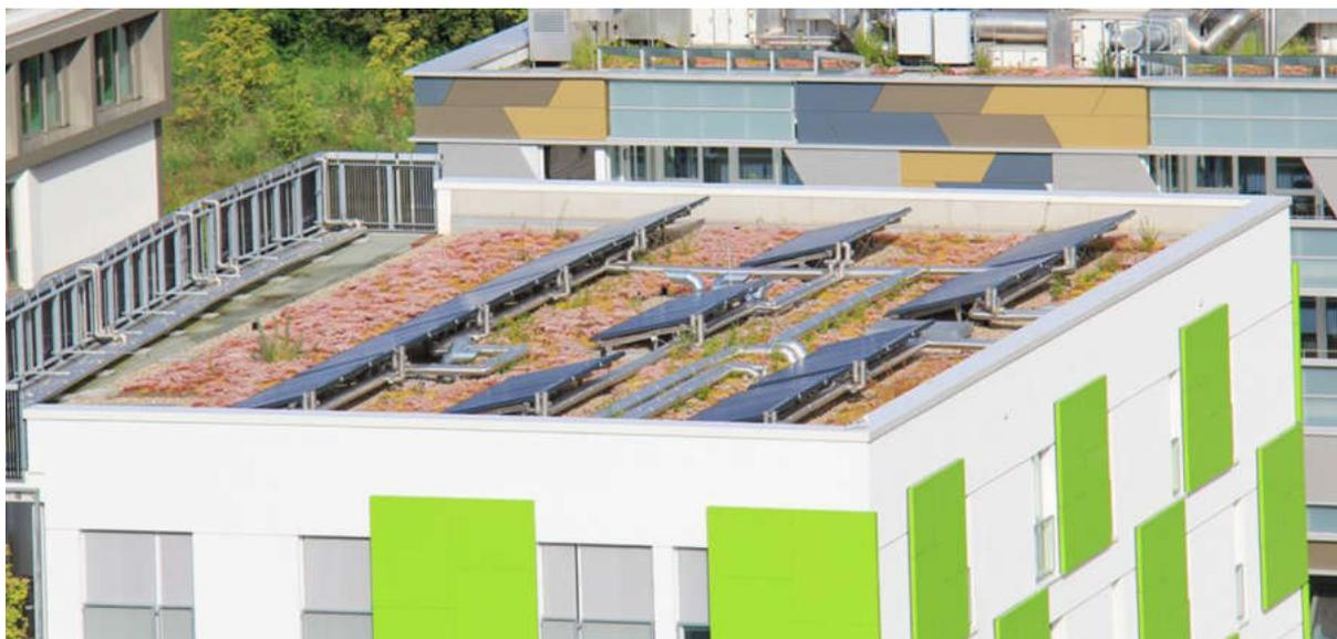
Abbildungen 5 und 6: Photovoltaikanlagen auf begrünten Flachdächern
